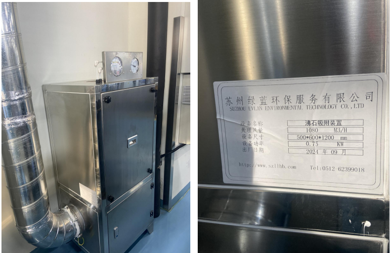
图 3-3 废气处理设备照片
