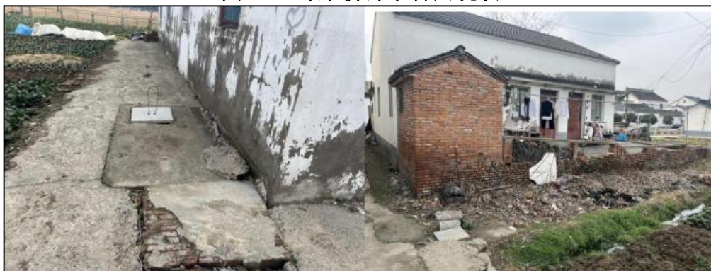
图2.7-6 许家桥现状污水管网空白区砖砌化粪池及污水散排现状
