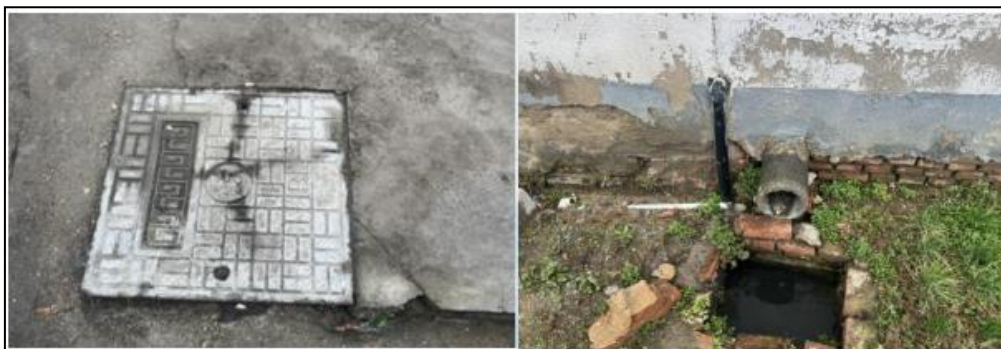
图2.7-7 庙下现状污水井及污水散排现状
