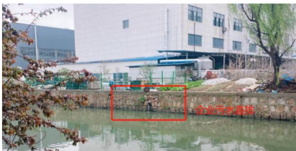
图2.7-19 企业雨污分流不彻底，部分污水直排现状
