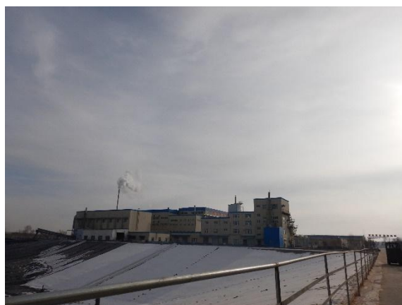
南侧无机暂存库
