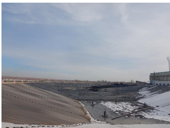
东侧柔性填埋场
