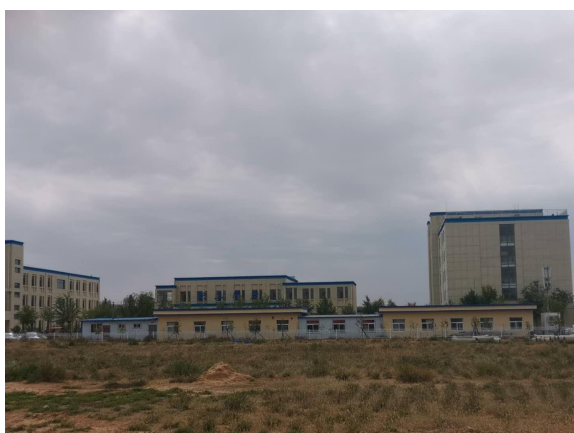
西侧职工宿舍楼及办公楼
