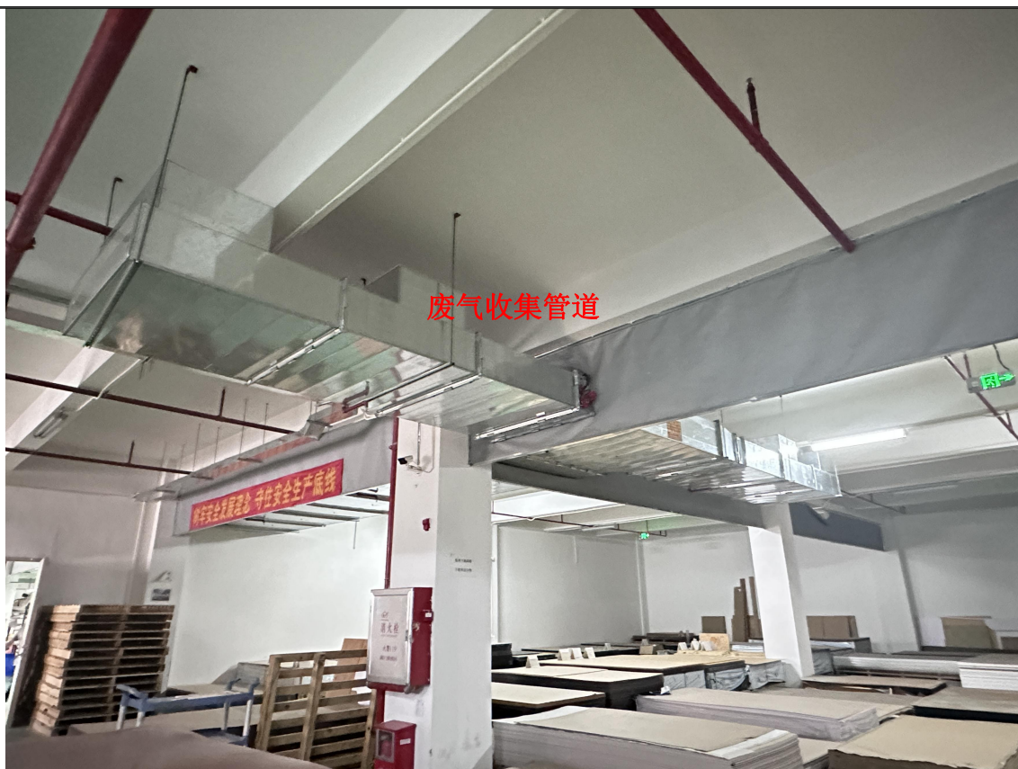
生产车间废气收集管道
