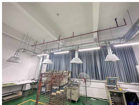
丝印车间废气收集
