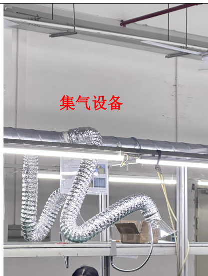
丝印车间废气收集
