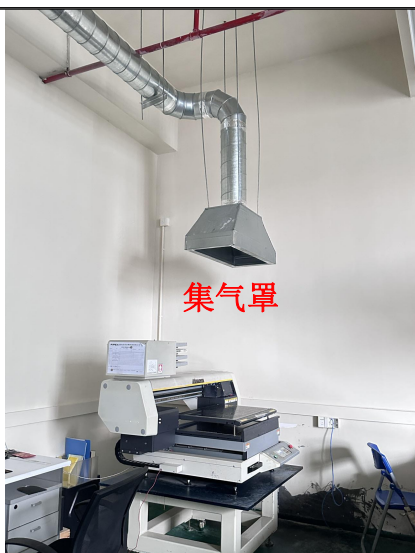
UV 打印车间废气收集
