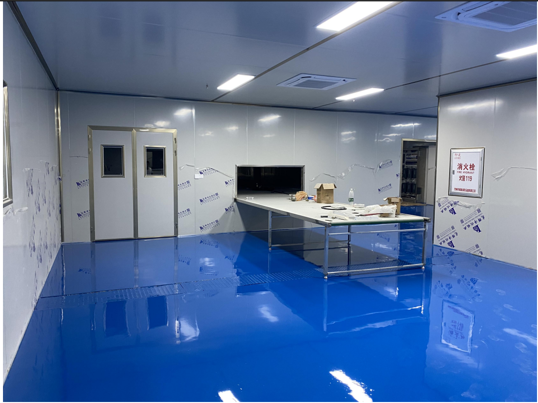
3#手喷底漆/橡胶漆线上下料口
