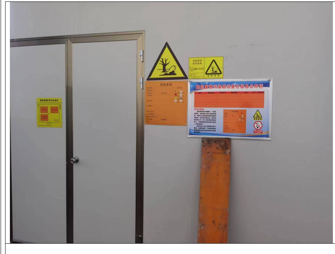
图 10 危废暂存间现场照片
