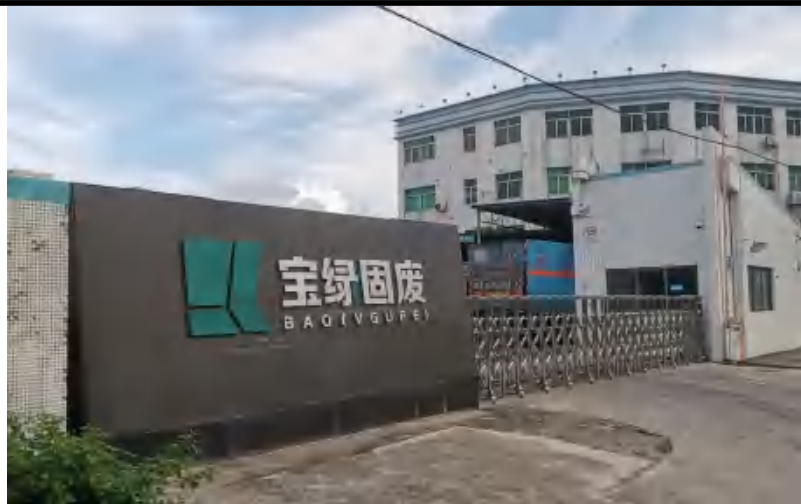
西面宝绿工业固体废物储运管理有限公司
