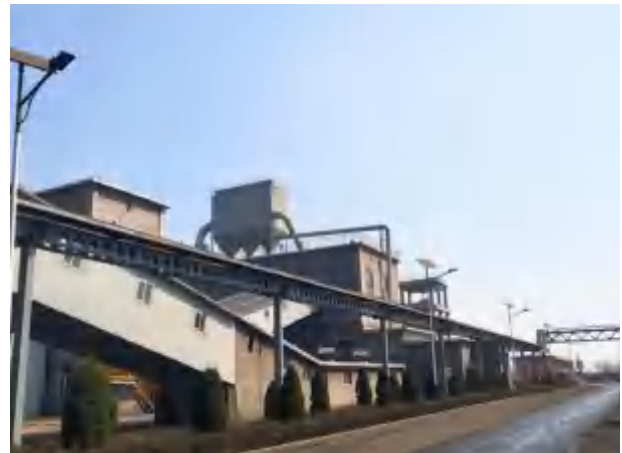
精煤粉碎除尘
