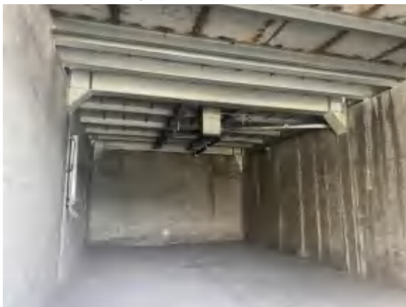
除尘器卸灰车间封闭
