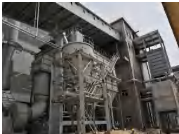
筛焦除尘地面站
