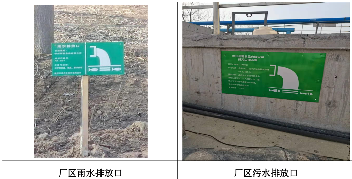
图 4.1-9 厂区雨水、污水排放口标识牌
