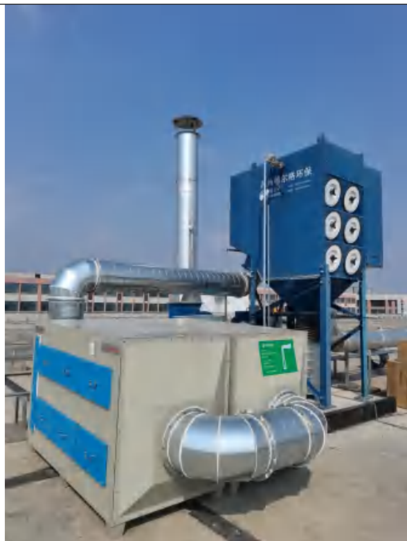
SMT生产线回流焊废气措施DA005
