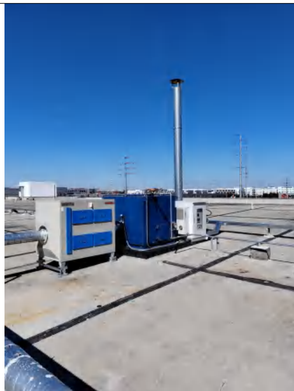
电子车间2层选择波峰焊废气、三防漆涂覆固化及清洗废气措施DA003
