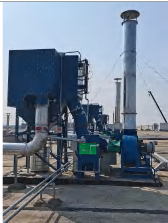
SMT生产线回流焊废气措施DA006
