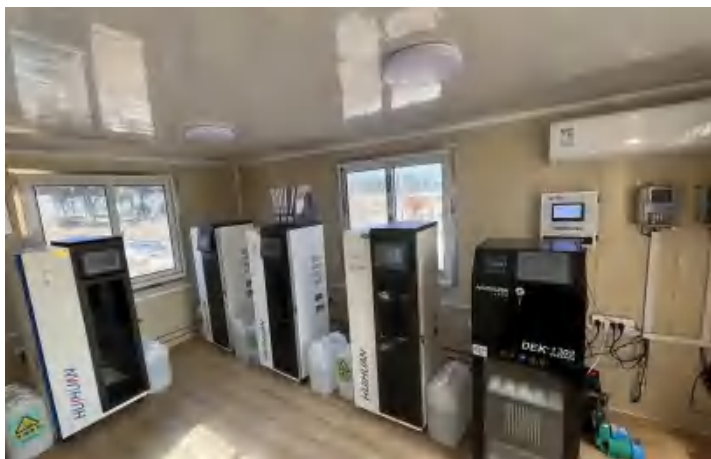
图 4.1-5 厂区污水排放口在线监测设施
