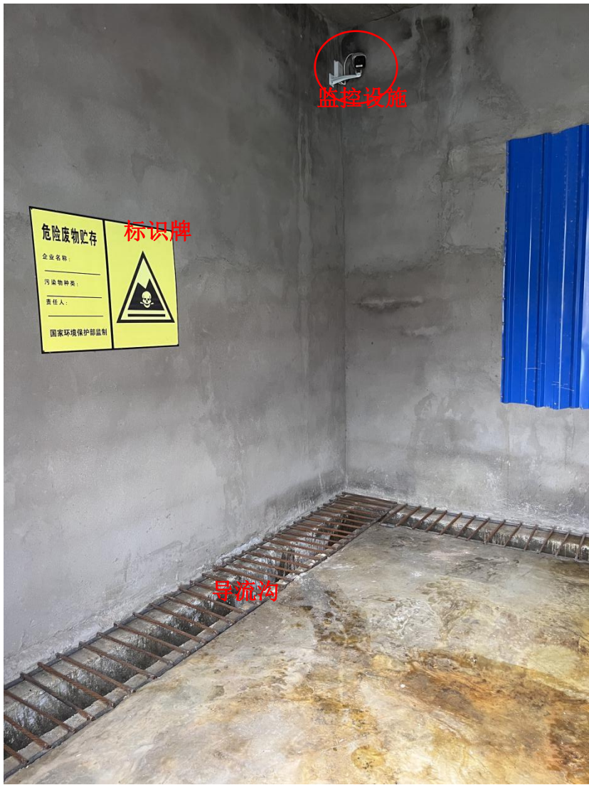
危废暂存间（内部）
