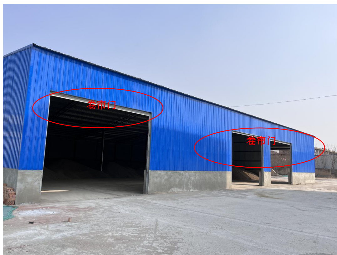
堆场密闭车间
