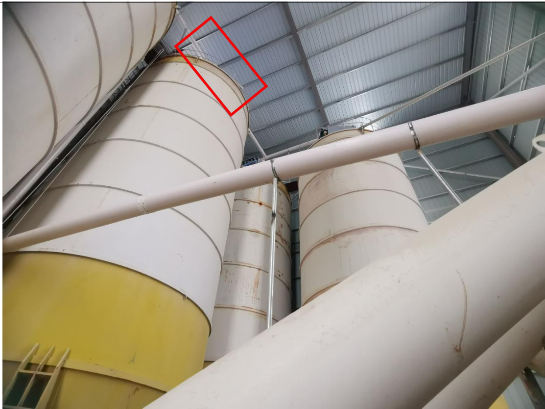
筒仓进口处不具备监测条件的照片（进口至措施距离太短）
