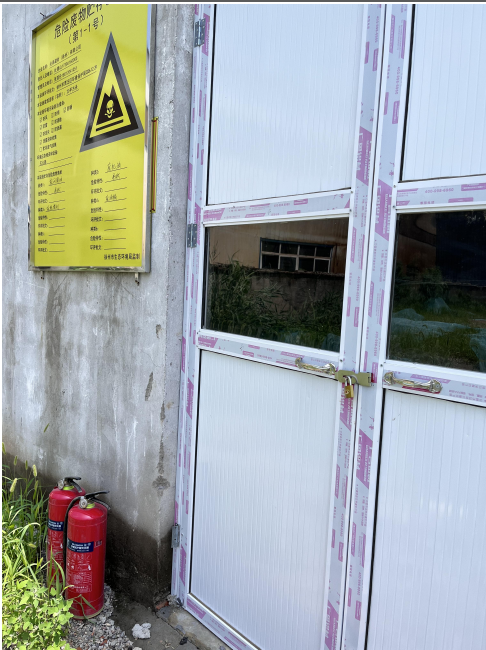
危废暂存间（外部）
