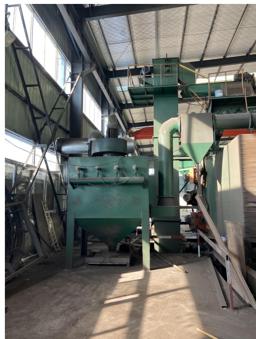
打磨、除锈工序滤筒除尘器
