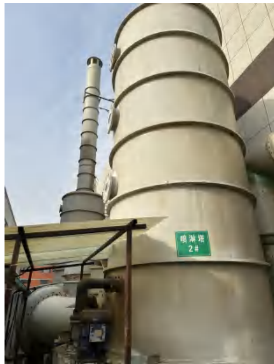
生产线废气喷淋塔
