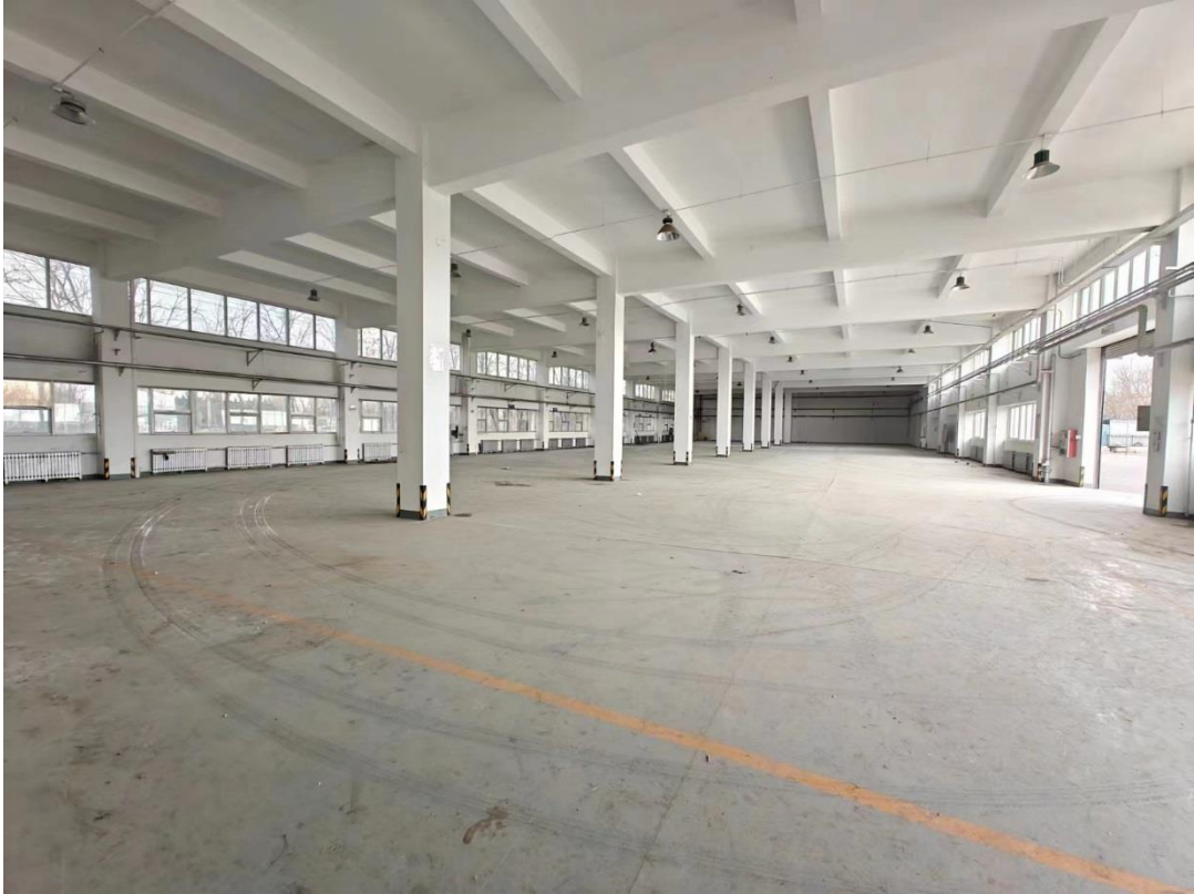
图 2-12 本项目所在厂房现状
