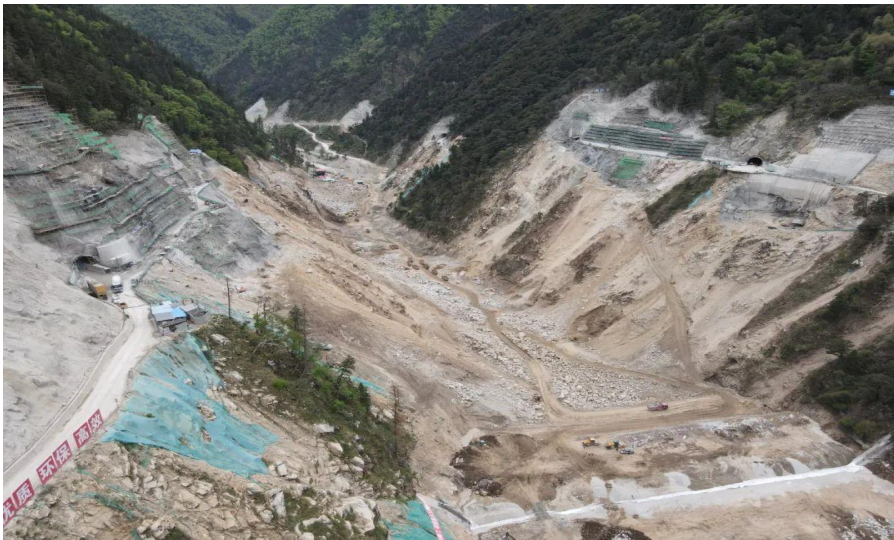
上图为巴拉电站下游河段，下图为巴拉电站建设现场
