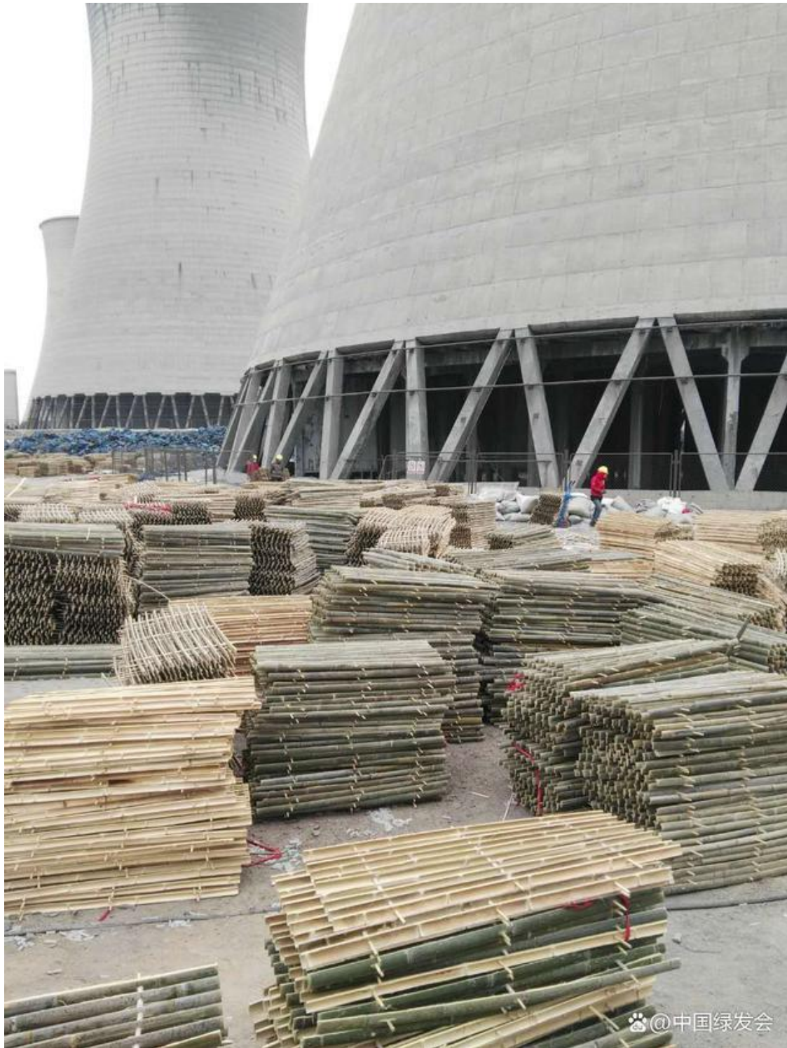
图片说明：中心与江苏一家公司成功研发的发电厂冷却塔竹格填料
