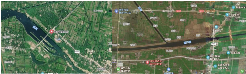
图 1-1 亳州涡河的大寺闸
