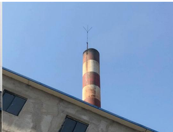
洁燃锅炉的烟囱比燃气锅炉通透无烟
