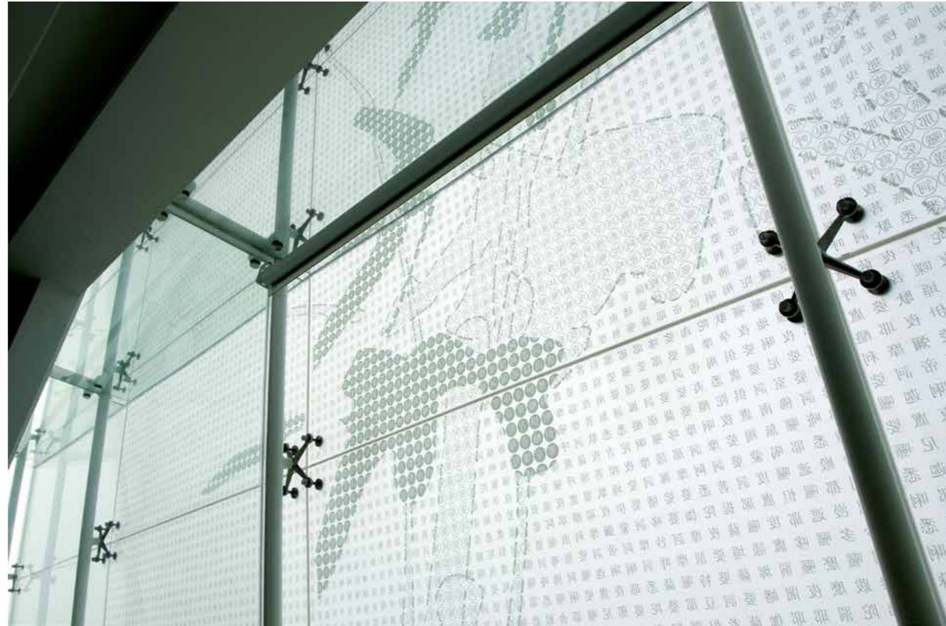
The solid color pattern can be achieved the required effect without countless silkscreens. 单色的多款图案，不需做无数的网版，却能做出所需的效果
