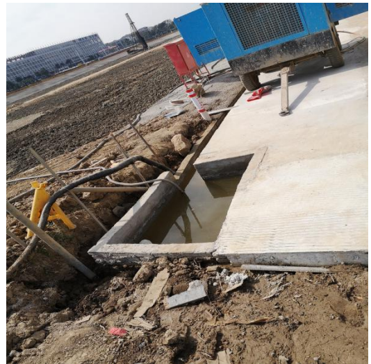
东北侧沉沙池
