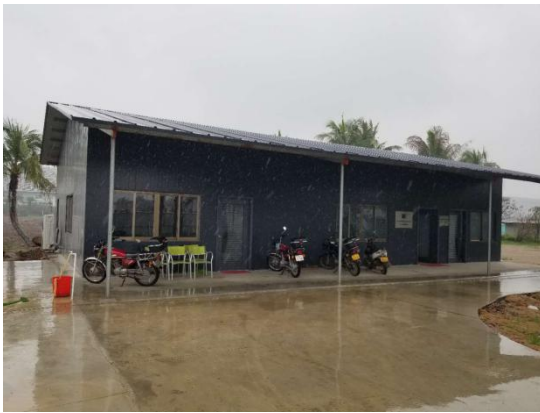
东侧施工营造区现状
