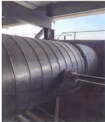
润版液、水性光油、水性油墨、专 色油墨、热熔胶生产工序废气 处理前
