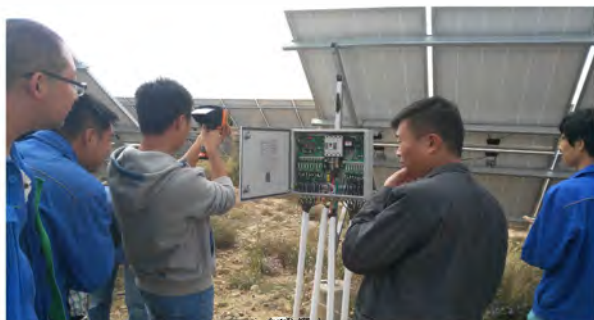
在青海共和某光伏电站用红外热像仪检测汇流箱异常发热点
