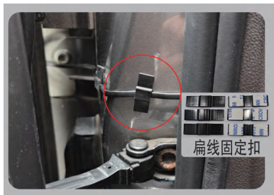
③将扁线用带胶固定扣粘贴车体
