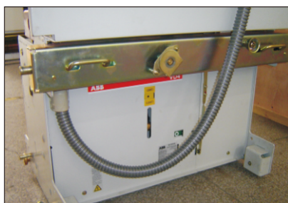
手车联锁机构
