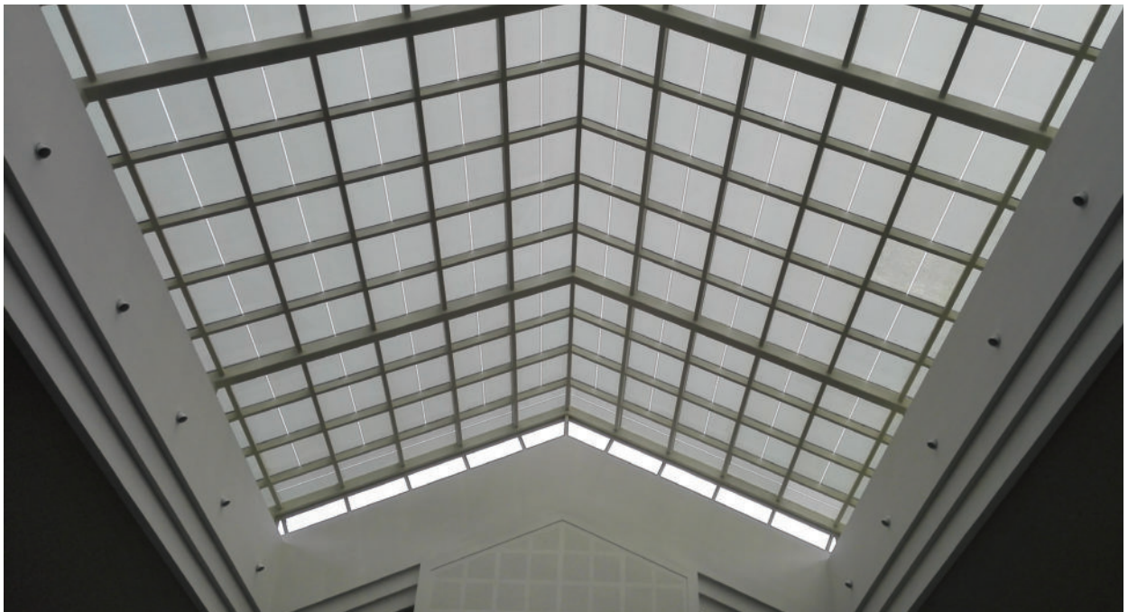
■ 天津养老院CdTe光伏透光屋顶电站
