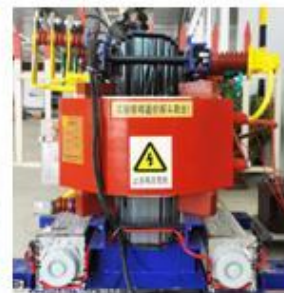
双绕组变压器侧视面
