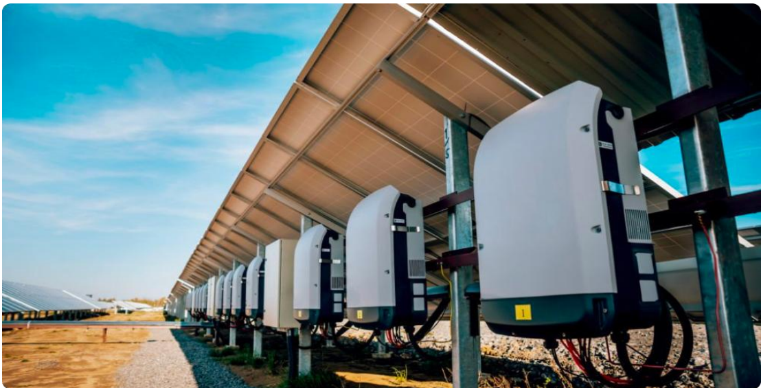
光伏逆变器效率测试
