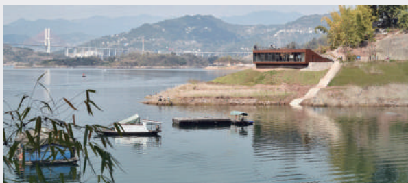
建筑体量临江出挑，与江景对望
