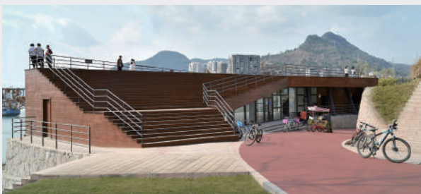
建筑屋顶后方与道路的关系
