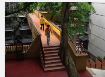
更新后廊桥成为居民安全通道
