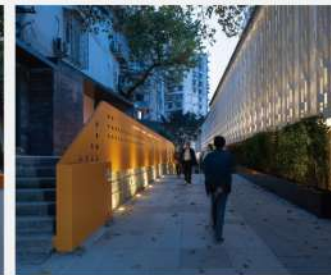
对临街建筑进行饰面代建更新
