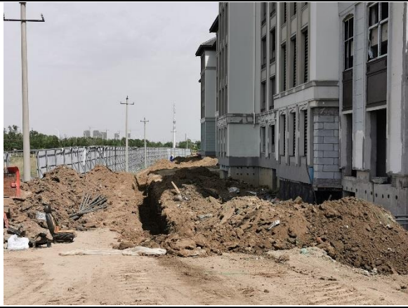
雨水排水工程
