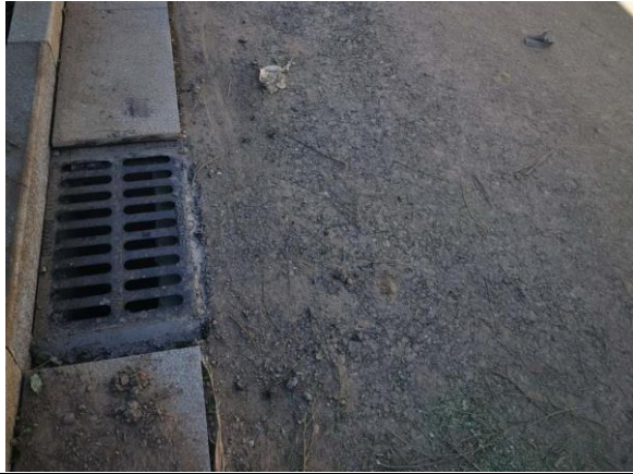
雨水排水工程
