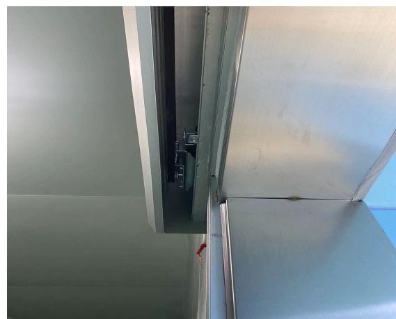
照片 6 患者通道防护门联锁装置
