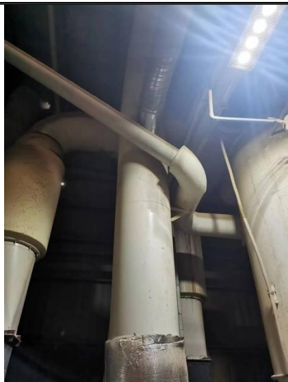
酶解发酵区废气收集管道整改后情况
