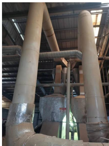
酶解发酵区废气收集管道整改后情况
