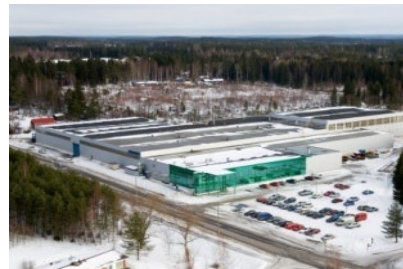
Kumera Machinery Oy Kylmäkoski, Finland
