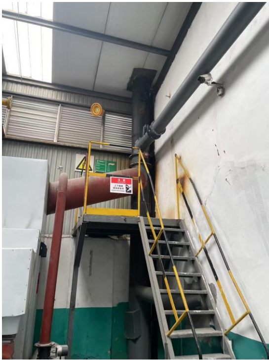
废气排放标识牌、采样平台及采样口
