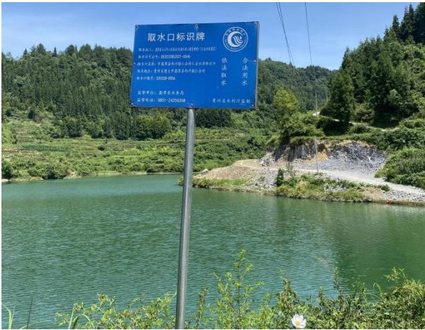
水库取水口现场照片
