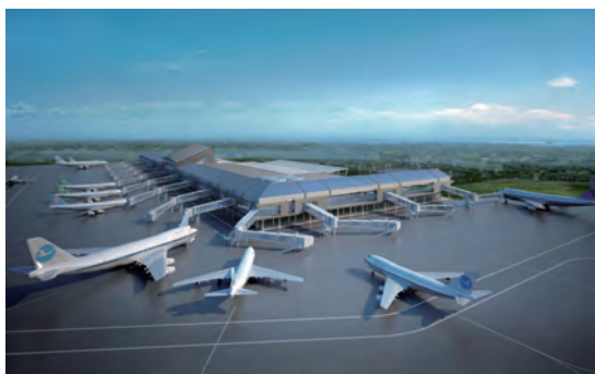
泉州晋江机场新航站楼
