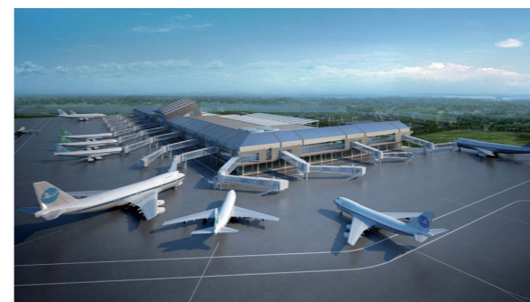
泉州晋江机场新航站楼
