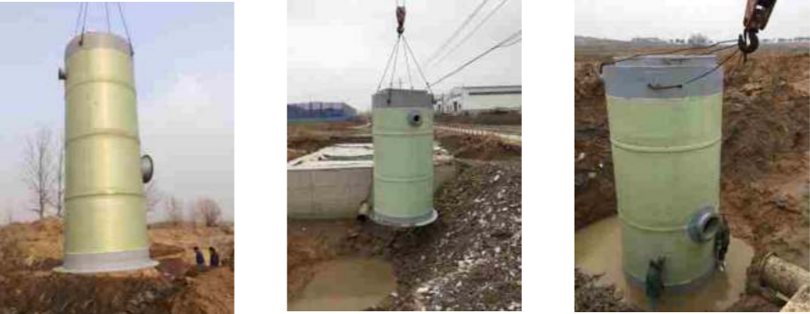
一体化预制泵站安装过程
